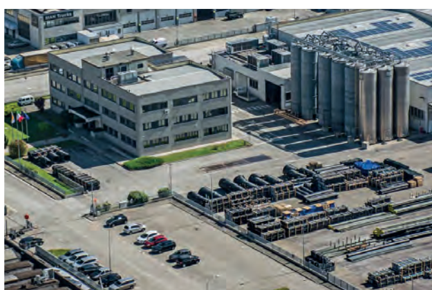
Centro Operativo - Castel Guelfo di Bologna (BO)
