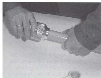
3. Bei **Bänninger Stabi-Verbund-Rohr** muß vor der Verbindung der Aluminiummantel abgeschält werden.
