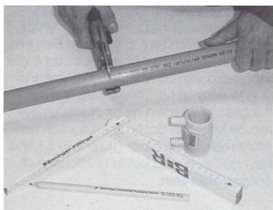
1. Rohr mit Kunststoffschere oder Rohrabschneider rechtwinklig abschneiden
